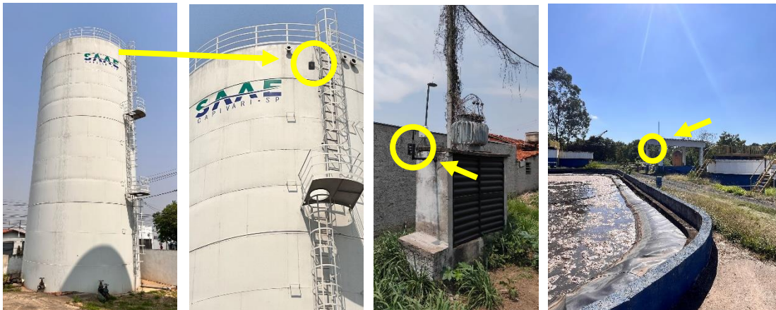
As setas amarelas indicam locais de instalação do Gateway Bolt 1.0 , garantindo conectividade ideal para o monitoramento remoto.
