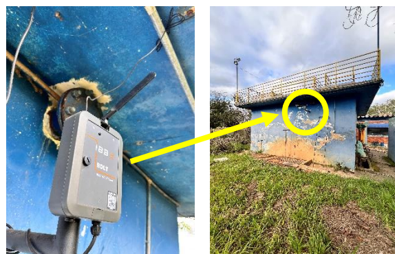
As setas amarelas indicam locais de instalação do Gateway Bolt 1.0 , garantindo conectividade ideal para o monitoramento remoto.
