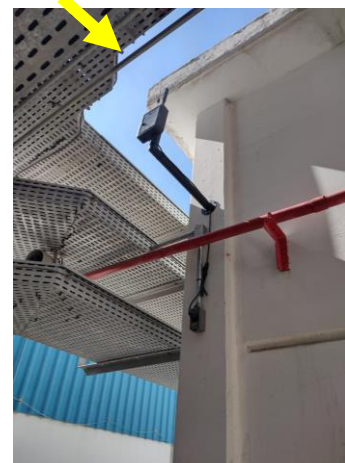
Dados transmitidos para plataforma Retina através do Gateway Bolt 1.0
