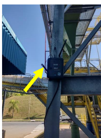
Dados transmitidos para plataforma Retina através do Gateway Bolt 1.0
