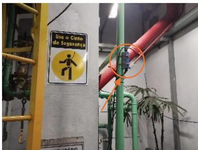
Figura: Medidor ultrassônico instalado
