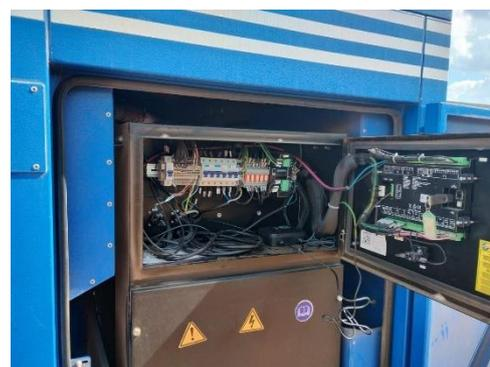
Figura: Conexão do multimetro ao Controlador DSE 8610
