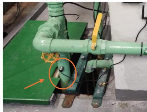
Figura: posicionamento do medidor de pressão
