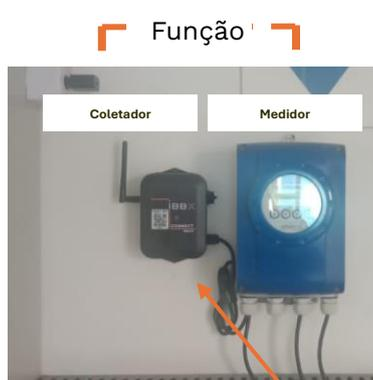
Figura: Instalação do Connect 2.0 com medidor Magnético
