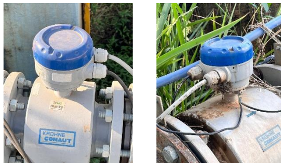
Figura: Conexão do transdutor
