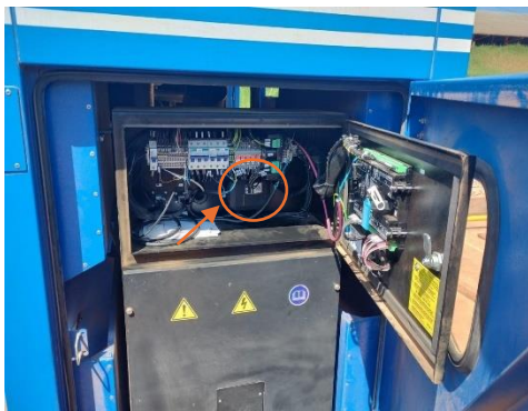
Figura: Fixação do Connect 2.0 na parte interna do painel
